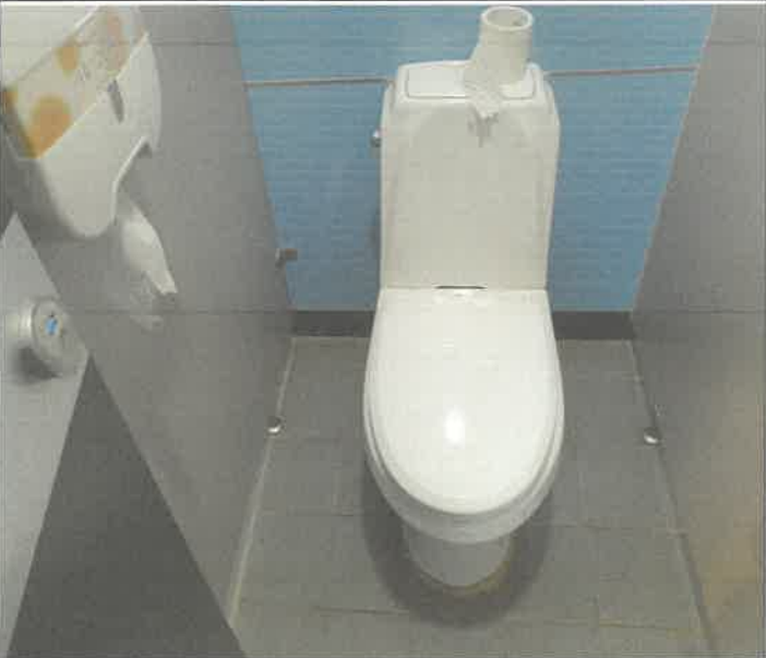
3층 남자 화장실 대변기 시트 파손 되어 1개소 교체
