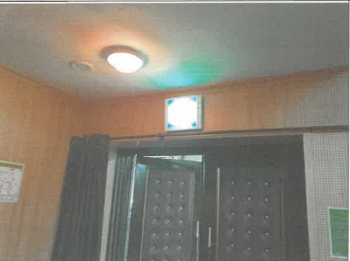
1층 청소년 극장 출입문 피난구 유도등 점등 불량 1개소 교체
