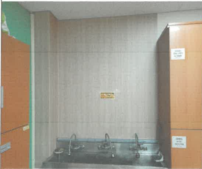
2층 유스6실 싱크대 벽 시트지 시공
