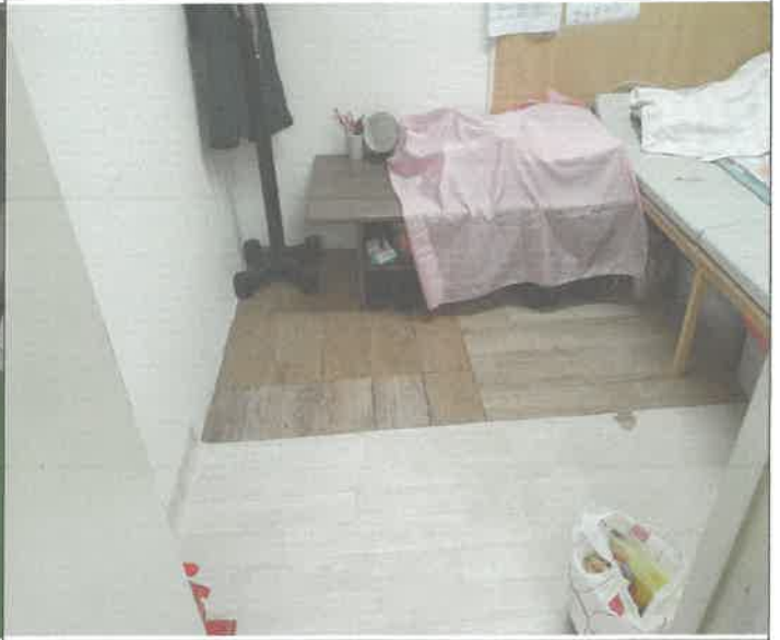
환경미화원 휴게소 마루시공
