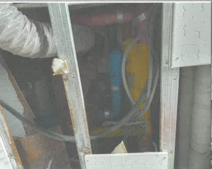
지하1층 여자 화장실 천장 배수관 밴딩
