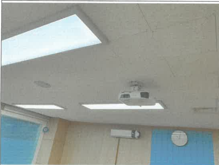
1층 방가후 아카 데미 교실 내부 빔프로 케이블선 교체 작업
