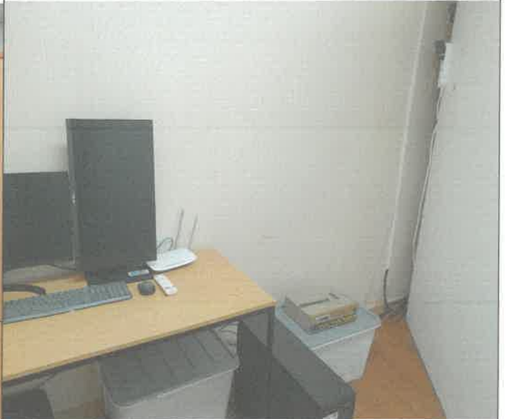
1층 수플렉스 통신라인 정리
