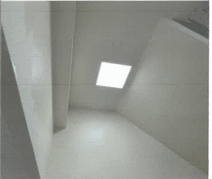
1층 중앙 복도 지하 1층 계단 방향 천장 사각 등 점등 불량 1개소 교체
