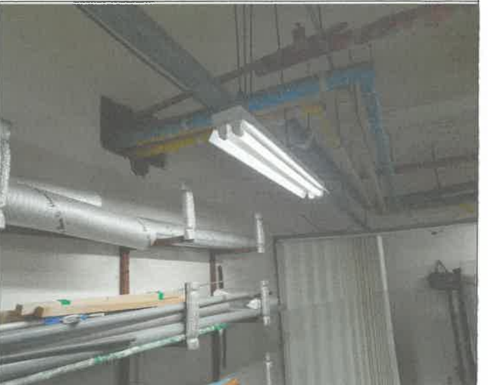
기계실 내부 1개소 LED 램프 소켓 교체
