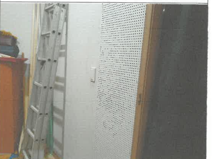
청소년 극장 내부 피아노 보관실 벽면 흡음판 부분편도 시공
